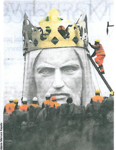
Robotnicy zakładają liny, dzięki którym dźwиг podniesie głowę z koroną
