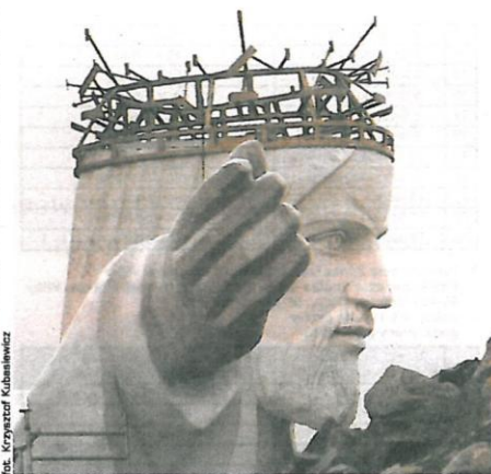
Na razie głowa Chrystusa Króla (przystrojona tymczasową koroną) oraz ramiona i dłonie znajdują się na ziemi. Teraz trzeba je wynieść do góry i zamocować na korpusie. Wtedy pomnik wraz z kopcem będzie miał 52 metry wysokości.
