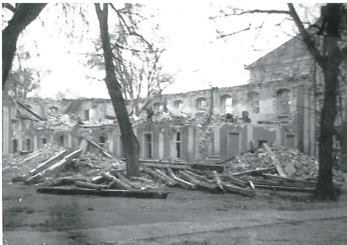
Waisenhauskirche während des Abrisses 1981
