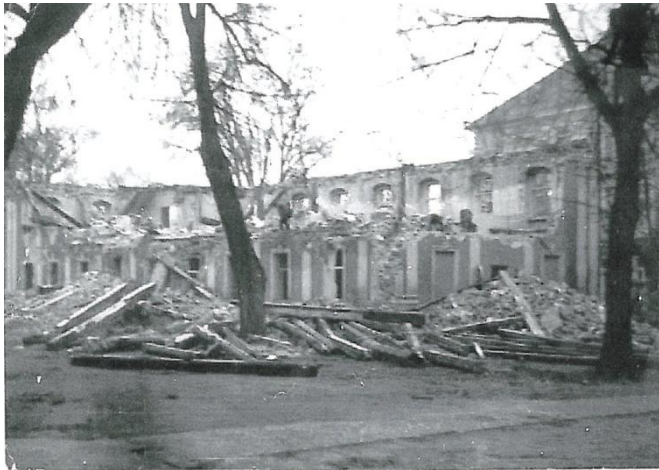
Waisenhauskirche während des Abrisses 1981
