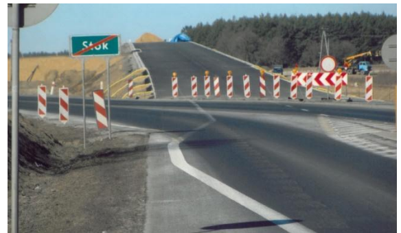
Nowy most w Stoku-Gronowie w III/2011 nad wykonywaną autostradą... bez chodnika dla pieszych. Czyj to projekt? Ujęcie od strony wsi Stok.
