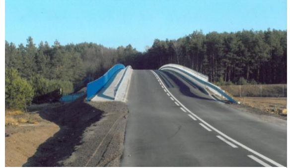
Most w Pożrzadle, 01.11.2011, nad A-2 po otwarciu – droga do Łagowa. Ujęcie od strony wsi Pożrzadlo.
