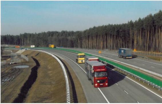
Autostrada A-2, XI/2011. Ujęcie z mostu w Pożrzadle.
