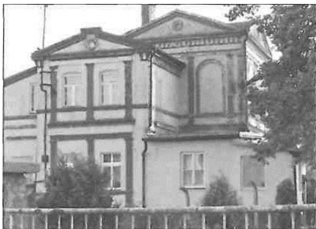
Pałac w Czystem. Elewacja zachodnia
